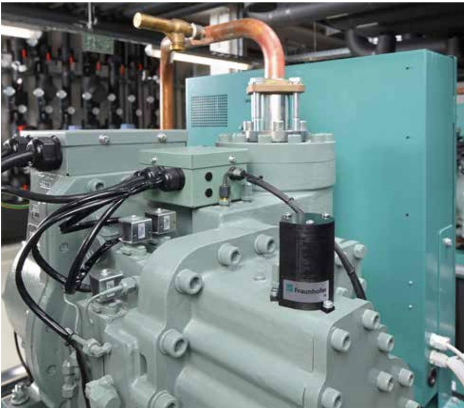
*Abb.: Vorhandene Vibrationen sinnvoll zur Betrieb von IoT-Sensoren in der Produktion nutzen ©Fraunhofer IIS/Kurt Fuchs*
