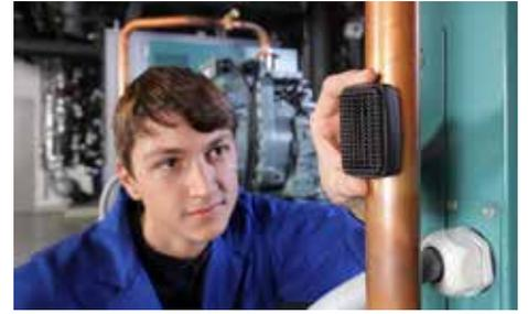
*Geringste Temperaturunterschiede reichen, um genügend Energie für den Betrieb von IoT-Sensoren zu gewinnen. ©Fraunhofer IIS/Kurt Fuchs*
