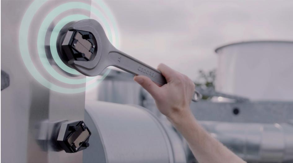
Abb. 1: Intelligente Schraubverbindung zur Überwachung von Schraubverbindungen
